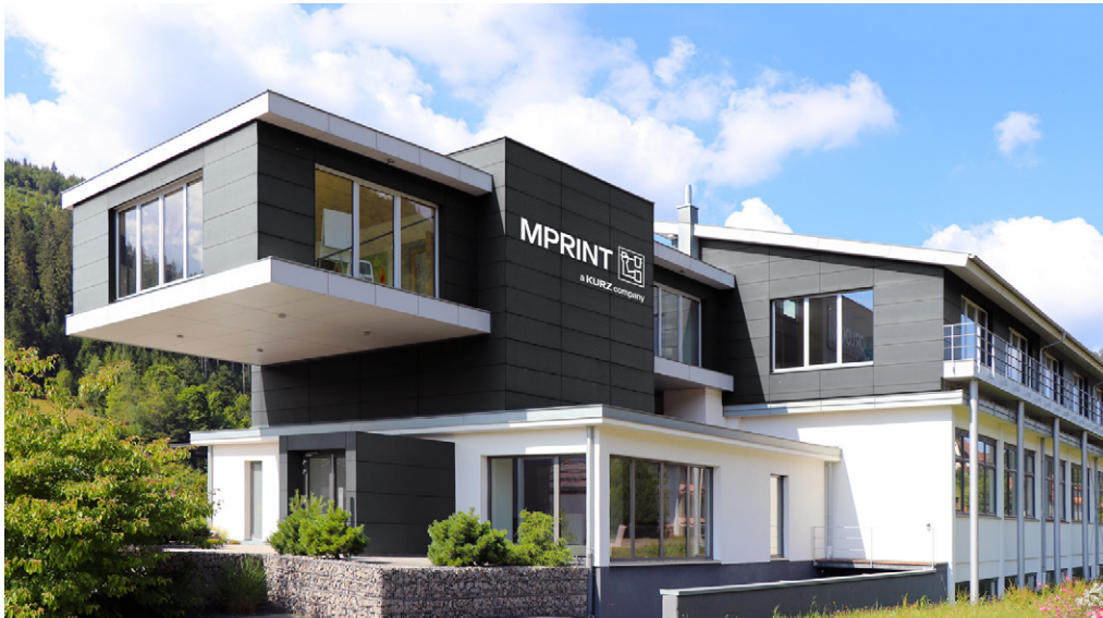
Abbildung 25: MPRINT Firmengelände; Quelle: KURZ
