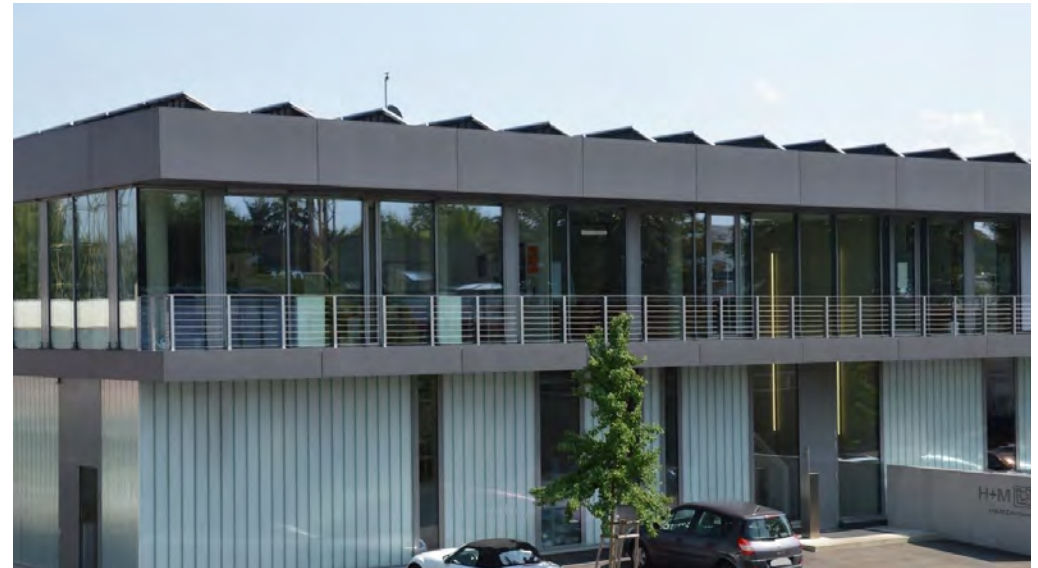
Abbildung 20: H+M Firmengelände; Quelle: KURZ
