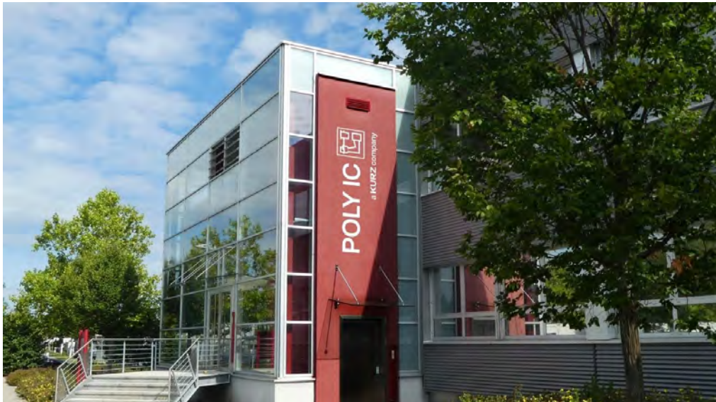
Abbildung 30: POLY IC Firmengelände; Quelle: KURZ
